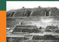
Erdunker zur Lagerung chemischer Kampfstoffe
