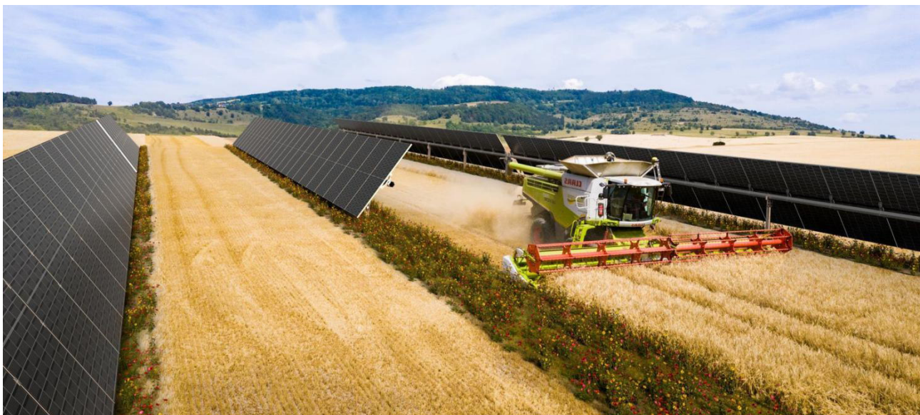
Bild 3.1: Beispiel eines hier geplanten Agri-PV Nachführsystems (Quelle: BayWa r.e., Ausschnitt)
