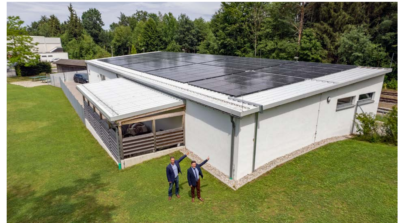
Die PV-Anlage auf dem neuen Technikgebäude hat eine Leistung von 60 kWp.
