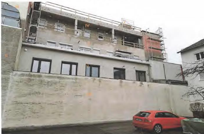
Bild mit Munastraße 2 im Zeitpunkt der Bauarbeiten.
