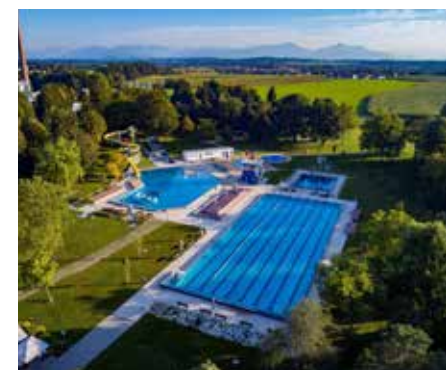
Am 11.07.2020 konnte das Franz-Haberlander-Freibad nach erfolgreicher Sanierung wieder eröffnet werden.
