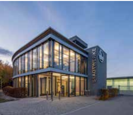
Das Verwaltungsgebäude der Stadtwerke Traunreut
