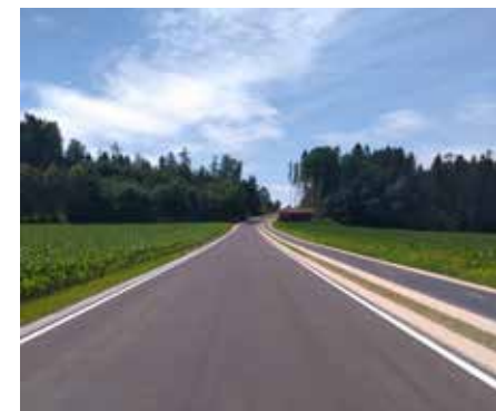
Die neue fertiggestellte Gemeindeverbindungsstraße zwischen Hörpolding und Haßmoning.
