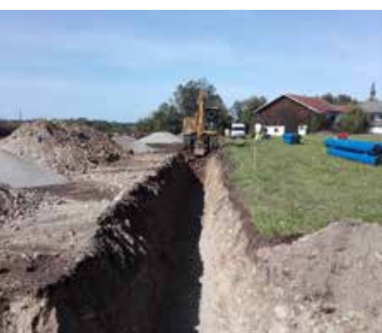
Hier entsteht die neue Querverbindung der Wasserversorgung.
