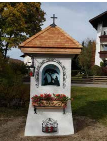
Bildstock Anning - Fasanenjäger nach der Sanierung
