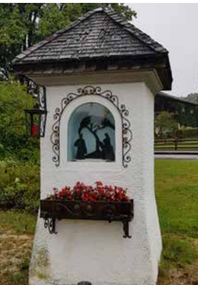
Bildstock Anning - Fasanenjäger vor der Sanierung
