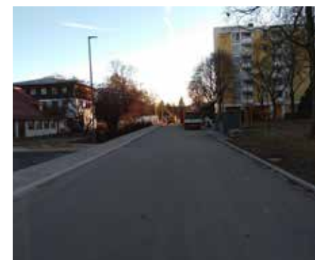
Umstellung der Straßenbeleuchtung auf moderne LED-Beleuchtung.
