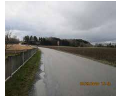
Die bestehende Gemeindeverbindungsstraße zwischen Hörpolding und Haßmoning vor der Sanierung.
